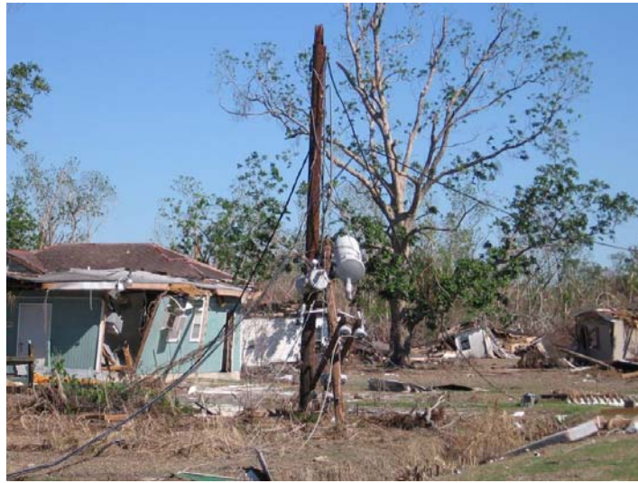
Fig. 8.10. Damaged pole
